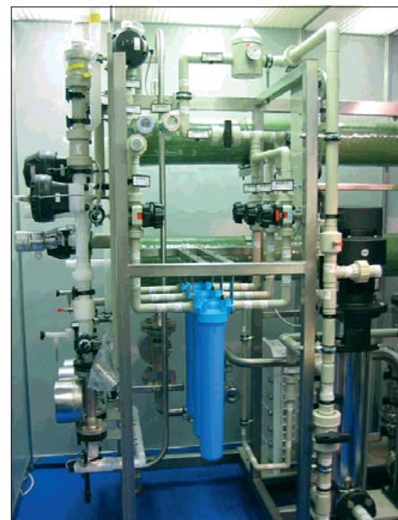
Bild 1: IR-geschweißte Rohrleitungen aus PP-R
