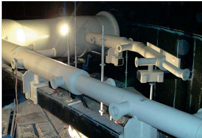
Bild 1: Bauteile aus nukleiertem Polypropylen für die Rauchgasreinigung von Braunkohlekraftwerken [1]
